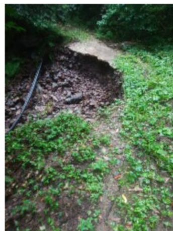
林道の崩落現場
