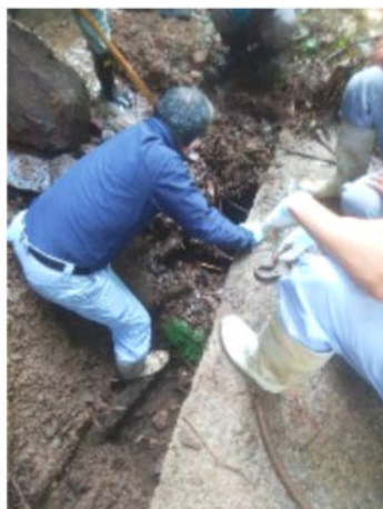
パイプラインの掘り出し
