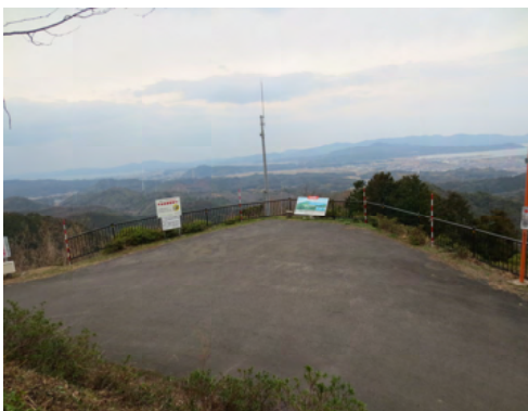
転落防止の防止柵
