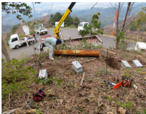
クレーン車を使ってベンチ2基を設置
